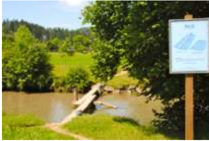
Abb. 1: Schwemmsteg an der Töss bei Steg
